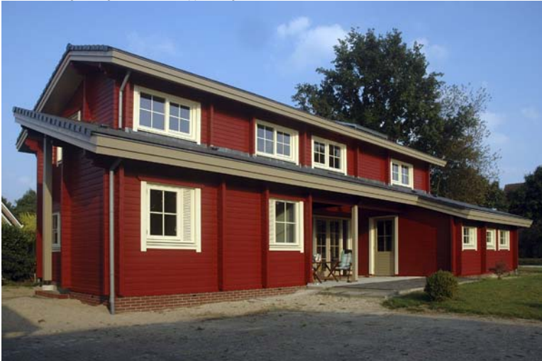
Houtstapelbouw woning - Didam
