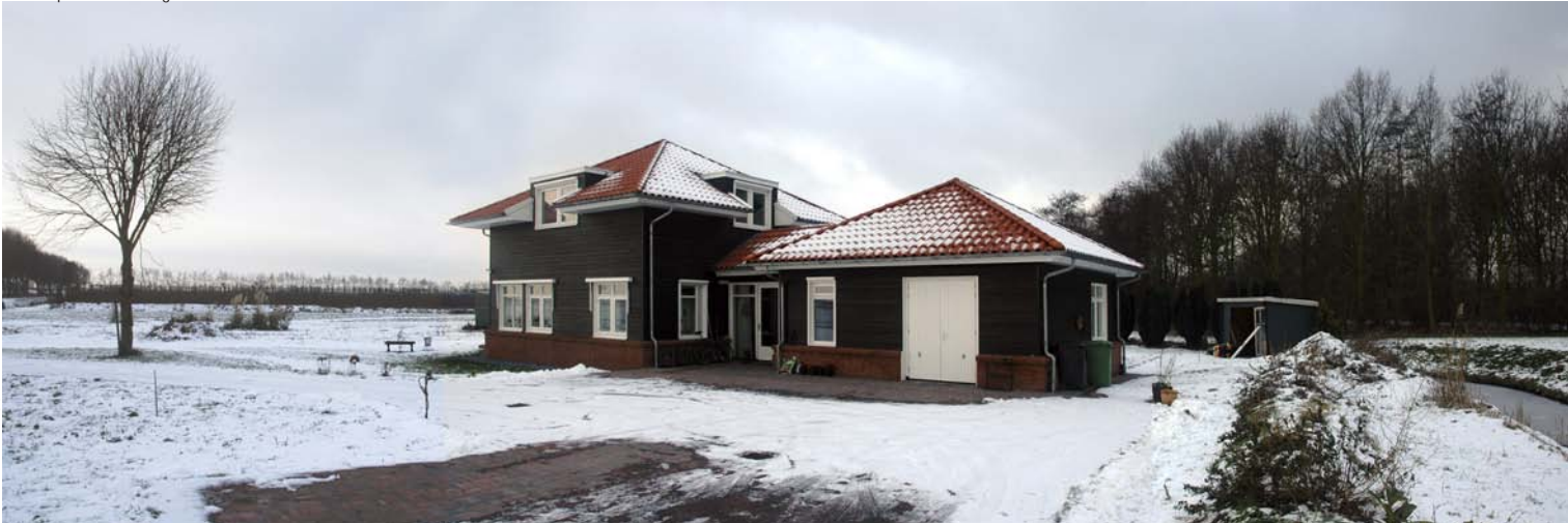
Houtskeletbouw (ecologische) woning met metselwerk - Vierpolders
