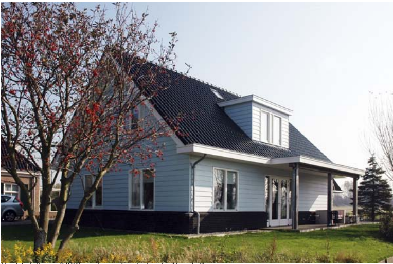
Houtskeletbouw (HSB) woning met metselwerk - Noordwijk
