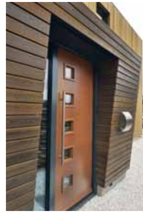
Aan de noordzijde vormt het element de ingang met een verbinding naar de eerste verdieping.
