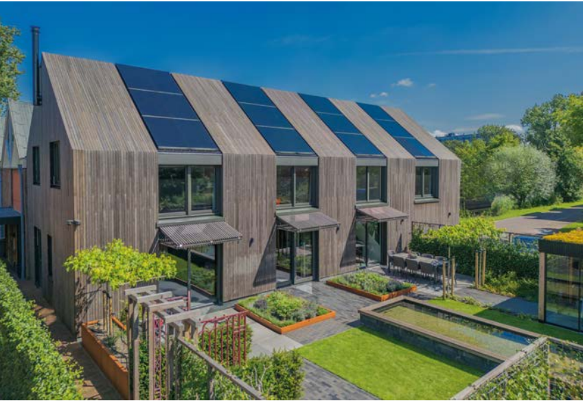
De elektrische vouwhefluiken sluiten naadloos aan op de bamboegevel en functioneren geopend als zonwerende luifel.
