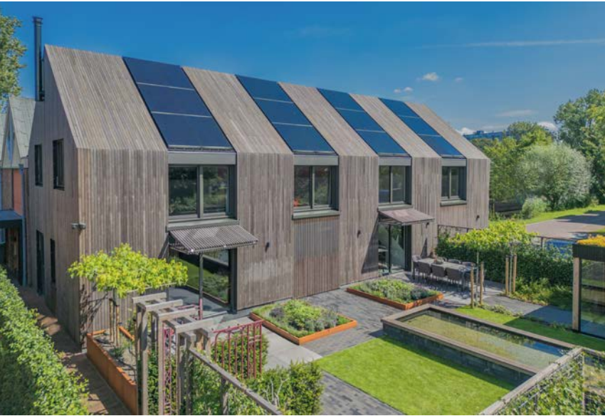
Gevel en dak zijn volledig bekleed met bamboe, waardoor een krachtig monolithisch volume ontstaat.
